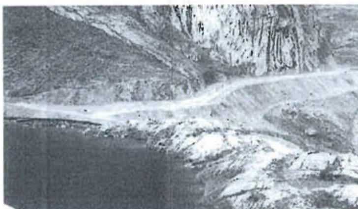
Fotografía 4. Vista general del canal margen izquierdo, llevando agua a Huayaoccocha
