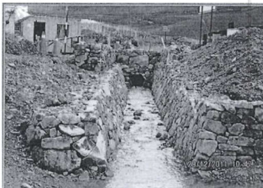
Fotografía N° 40: Recomendación N° 8. Zona de Chancas – Ingreso al Proyecto, se constató que la infraestructura para la derivación de aguas de escorrentías superficial fue revestido con un enrocado, para evitar el arrastre de sólidos e impactar a los pastos naturales en la zona de descarga al curso natural del agua. Las superficies no están revegetadas
