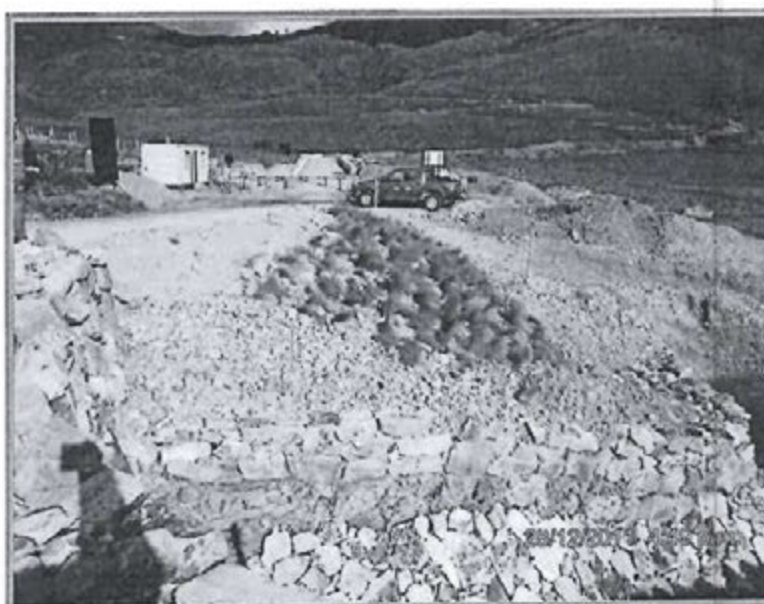
Fotografía N° 186: Observación N° 8. En las pozas de sedimentación y costados de los canales de escorrentía - costado Estación Bravo 4 se observó, suelos disturbados. Las lluvias producen arrastre de sólidos al cauce de aguas de lluvia. Impacto Ambiental: Impactando al medio natural (Suelo)
