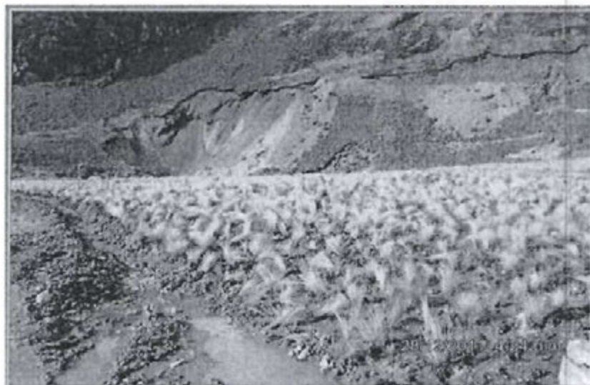
Fotografía N° 54: Recomendación N° 11. Parte alta zona de Chancas, se constató la presencia de taludes disturbados por la construcción de vías de acceso y que no fueron remediados
