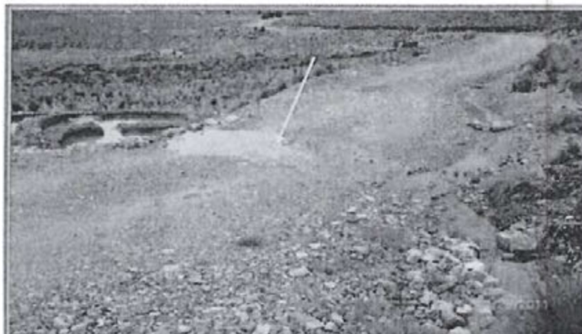
Fotografía N° 27: Recomendación N° 5. En el punto de coordenadas UTM WGS 84, 795 849E, 9 228 431N y cota 3 809, se constató que en la carretera no se construyó el badén para el cruce del agua de escorrentía colectada por la cuenta y que es derivada al curso natural de agua, sólidos e impactar a los pastos naturales en la zona de descarga al curso natural del agua
