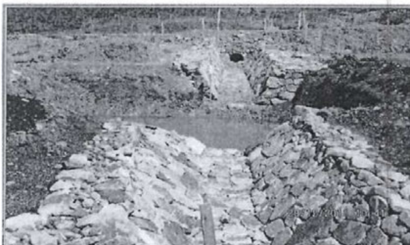
Fotografía N° 39: Recomendación N° 8. Zona de Chancas – Ingreso al Proyecto, se constató que la infraestructura para la derivación de aguas de escorrentías superficial fue revestido con un enrocado, para evitar el arrastre de sólidos e impactar a los pastos naturales en la zona de descarga al curso natural del agua. Las superficies no están revegetadas
