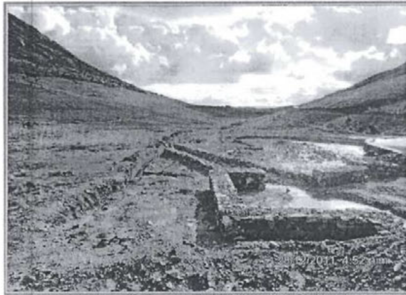
Fotografía N° 44: Recomendación N° 8. Zona de Chancas – Ingreso al Proyecto, se constató que la infraestructura para la descarga de aguas de escorrentías superficial al cauce natural, está revestida de un enrocado, para evitar la erosión y arrastre de sólidos al curso natural del agua. Las superficies no fueron revegetadas.
