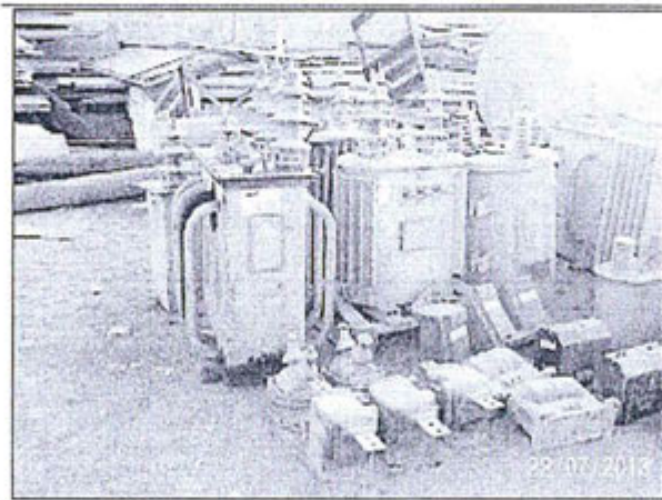
Fotografías N° 10: disposición de residuos peligrosos (transformadores con aceites dieléctricos) derramados en suelo no impermeabilizado. Subestación Eléctrica de Transmisión Yarada.
