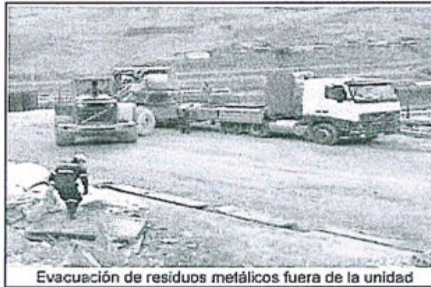
Evacuación de residuos metálicos fuera de la unidad
