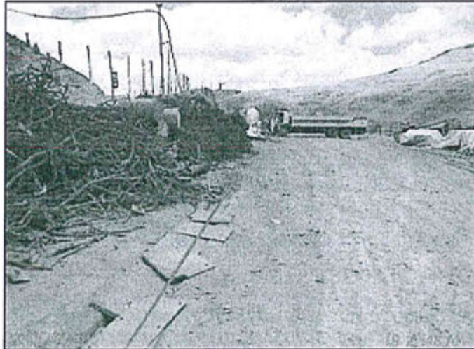
Fotografía N° 64 del Informe de Supervisión: "(...) En el Nv. +80, depósito de tránsito N° 1 de residuos industriales, en las coordenadas UTM WGS-84 8'827 689N, 367 777E, se encuentra obstruido (flecha roja) "el canal de captación de aguas de escorrentía" con sedimentos y materiales de chatarra que se depositan temporalmente."
