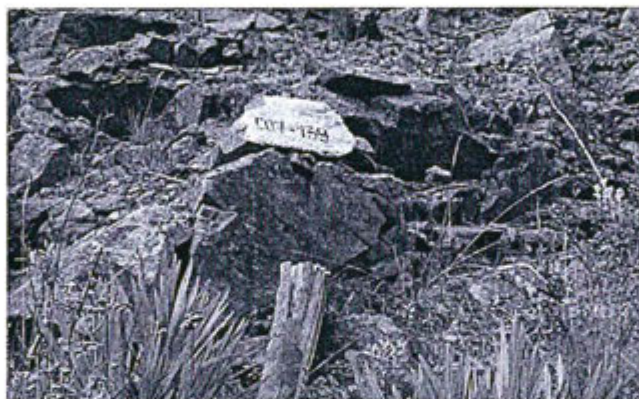
FOTOGRAFIA N° 6: En la plataforma C07-139 se observó derrumbes de rocas y las laderas no presentan cobertura vegetal. Coordenadas N: 9326048; E: 690981.
