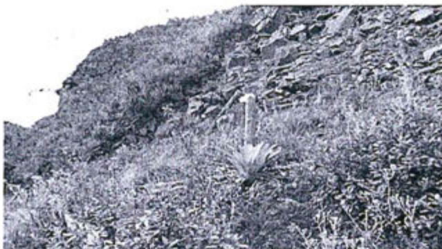
FOTOGRAFIA N° 8: Otra vista de la Plataforma C07-139 donde se observa derrumbes.
