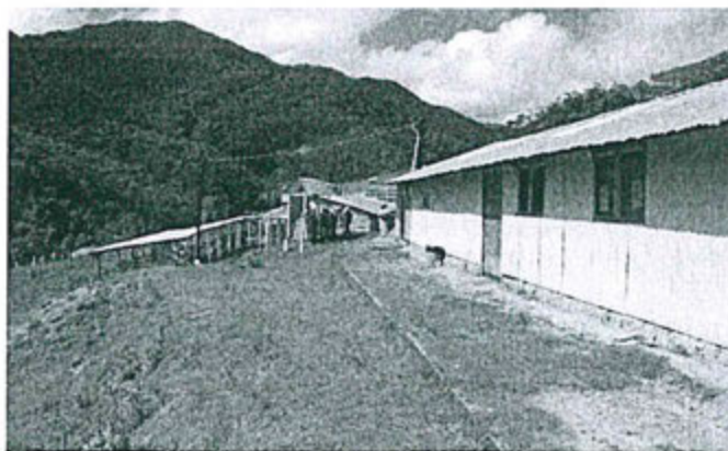
FOTOGRAFÍA N° 26: Campamento no desmantelado, oficinas y almacén.
