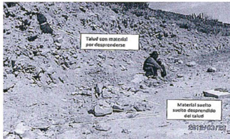
Foto N° 6: El talud de las plataformas de perforación diamantina ubicada en las coordenadas UTM WGS - 84 Este: 30545, Norte: 8088555.
