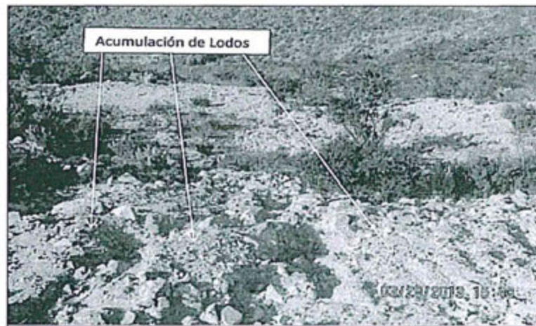
Fotografía N° 7: En la Plataforma de Perforación diamantina ubicada en las coordenadas UTM WGS 84; Este: 379336, Norte: 8089180, se encuentra lodos acumulados.
