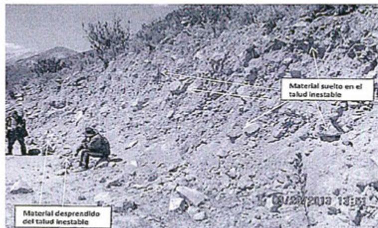
Foto N° 6-A: El talud de las plataformas de perforación diamantina ubicada en las coordenadas UTM WGS-84 Este: 380545, Norte: 8088555.
