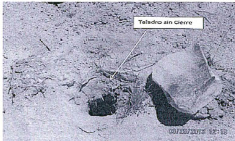
Foto N° 9: Todas las plataformas de perforación diamantina encontradas durante la supervisión se encuentran sin código, tal como indica su DIA. Y 2 taladros de perforación sin cierre.
