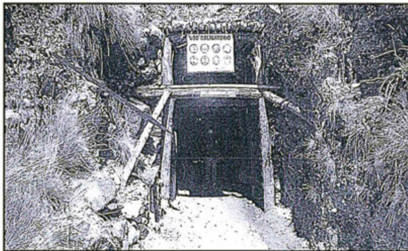
Fotografía N° 19. Bocamina Santiago Mayor, localizado en las coordenadas UTM WGS 84 8 688 958N, 363 710 E, se observa el enmaredado y reacondicionamiento de la labor minera y la presencia mínima de agua procedente del interior de la mina.
