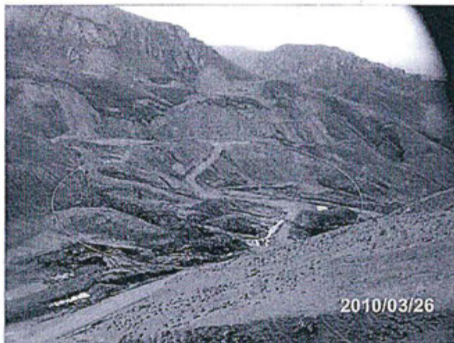
Fotografía N° 41 del informe de supervisión del año 2010: Nuevo depósito de desmontes Rumiallana, se observa el deslizamiento del talud de la base de la quebrada, por la ejecución de trabajos en la zona, no se han ejecutado obras de remediación, UEA Cerro de Pasco.
