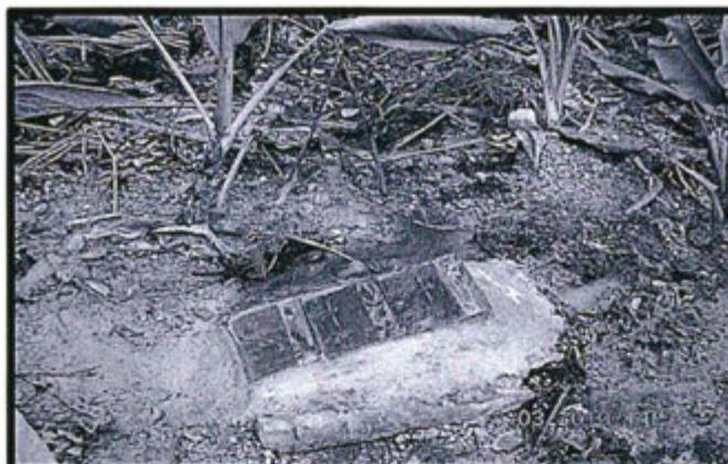
Fotografía N° 039: Plataforma N° 04 se observa el sellado mediante placas de hierro empotradas en concreto (se observa 03 taladros en el mismo punto de perforación).
