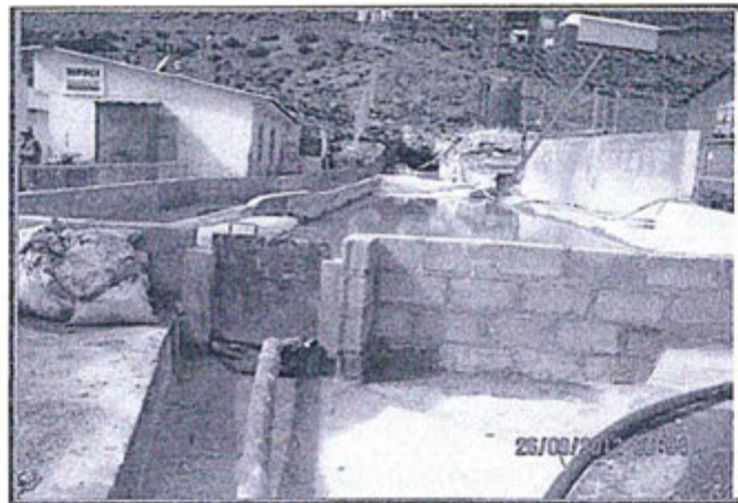
FOTOGRAFIA N° 38.- Zona Huacracoche: Otra vista de la poza de concreto que almacena las aguas que se derivan por la bocamina de Huacracoche. Observación N° 8 – 2012.
