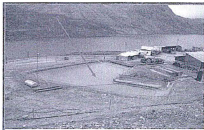
FOTOGRAFIA N° 39.- Zona Huacracoche: Vista de la poza impermeabilizada que almacena las aguas que se derivan por la bocamina de Huacracoche. Observación N° 8 – 2012
