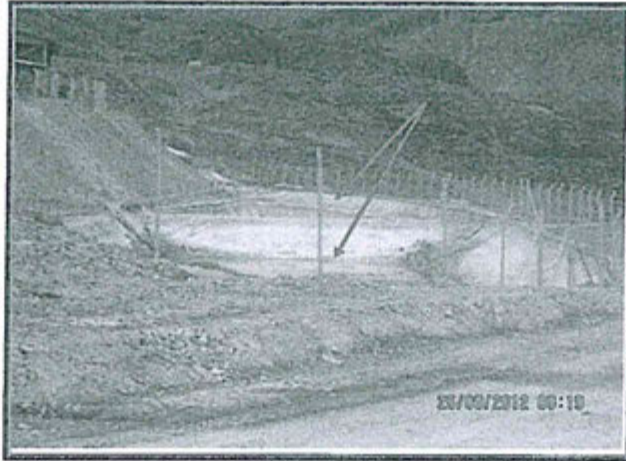
FOTOGRAFIA N° 40.- Vista de las 02 pozas sedimentadoras e impermeabilizadas con geomembrana, ubicadas debajo del área de oficinas de Ticio, que forman parte de la planta de tratamiento de aguas de mina zona Huacrachocha. Observación N° 8 - 2012.
