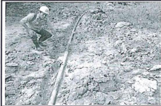
**Fotografía N° 13:** Muestra línea de flujo del pozo inyector MA-29, se observa el COPLA a través del cual se produjo el derrame; se puede observar también que la línea cruza la ubicación del Pozo MA-22. Coordenadas: 0504566/ 9189690.
