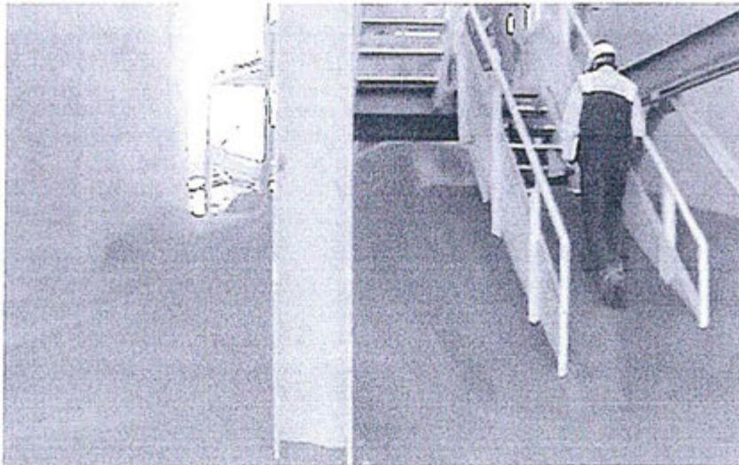
Fotografía N° 28: Parte posterior de los silos, escalera que comunica a la parte superior del silo, presencia de concentrados de fosfatos provenientes del transporte desde la planta de secado hacia el silo, expuestos a la acción de viento.
