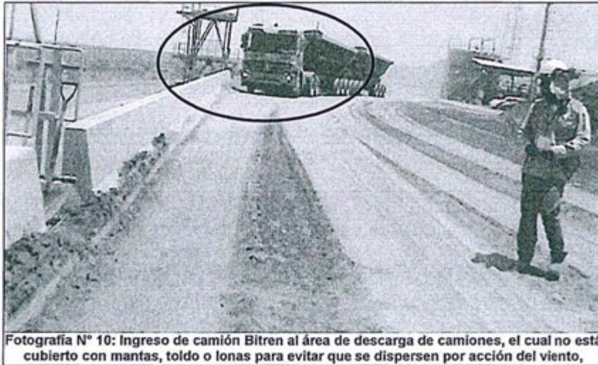
Fotografía N° 10: Ingreso de camión Bitren al área de descarga de camiones, el cual no está cubierto con mantas, toldo o lonas para evitar que se dispersen por acción del viento,
