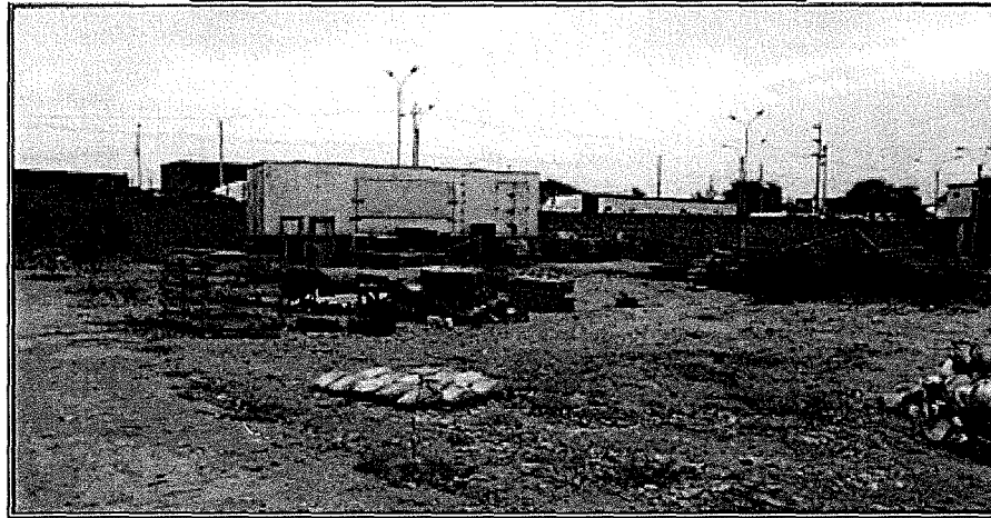
Fotografía N° 18 del Informe de Supervisión
