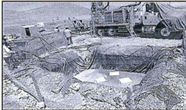
Foto N° 4: Poza de lodos de la Plataforma ANT10-041, situado en las coordenadas UTM WGS84, N: 8 345959, E: 242915. Se encuentra impermeabilizada mediante mantas plásticas (vinimantas) con cerco perimétrico. La poza no cumple con las medidas establecidas en su EIA.
