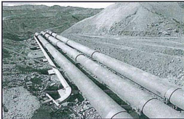
Foto N° 85: Observación N° 5. Las tres (03) tuberías metálicas de 20" de diámetro que llevan los relaves del espesador al depósito (tajo Chabuca Este Oeste), no cuentan con sistema de contingencia en caso de producirse derrames.
