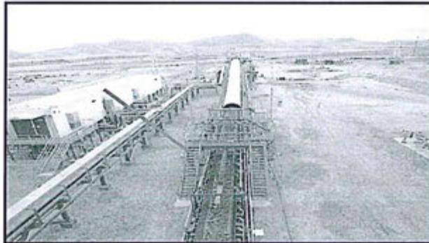
Foto N° 47: Faja transportadora overland de 54" de ancho y 6.52 Km de longitud, que lleva el mineral chancado hacia la pila de almacenamiento en la planta concentradora. Una parte de la faja está protegida para evitar el arrastre de polvo. No está toda la faja protegida debido a que se hacen ajustes.
