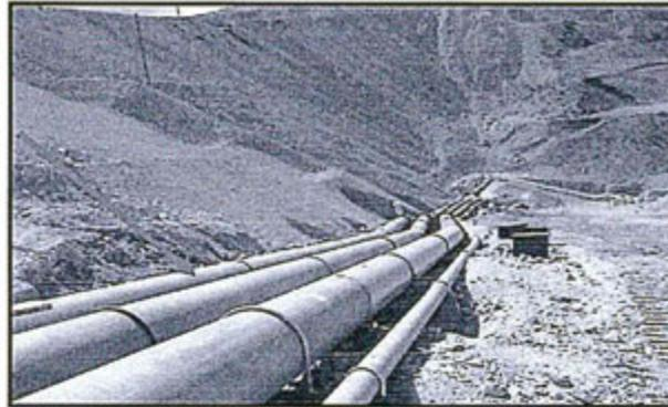
Foto N° 86: Observación N° 5. Otra vista de las tres (03) tuberías metálicas de 20" de diámetro que llevan los relaves al depósito (tajo Chabuca este oeste), que no cuentan con un sistema de contingencia en caso de producirse derrames.
