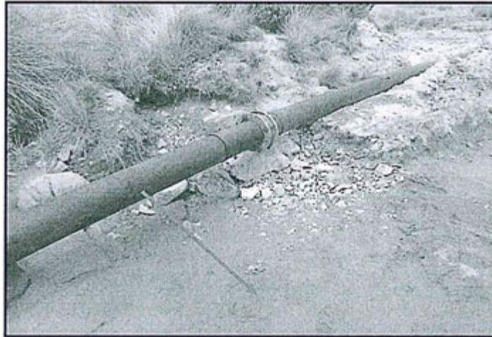
FOTO N° 61: Observación N° 3. Empalme de la tubería HDPE de 8" de diámetro, que lleva las arenas gruesas de relaves al dique de la presa Huinipampa, donde en los alrededores de la vía de acceso se observa derrame de relaves, producidos por la limpieza de la tubería.
