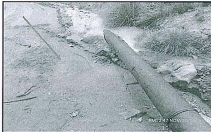
FOTO N° 62: Observación N° 3. Otra vista de la tubería HDPE de 8" de diámetro, que lleva las arenas gruesas de relaves al dique de la presa Huinipampa, donde en los alrededores de la vía de acceso se encuentran derrame de relaves impactando suelo, producto de la limpieza de la tubería.
