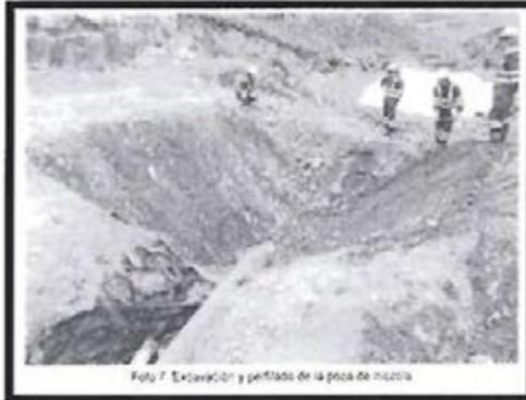
Foto 7. Excavación y perfilado de la poza de mezcla
