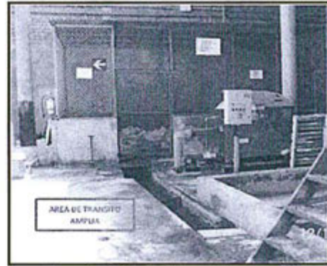
Almacén Central de residuos sólidos peligrosos húmedos
