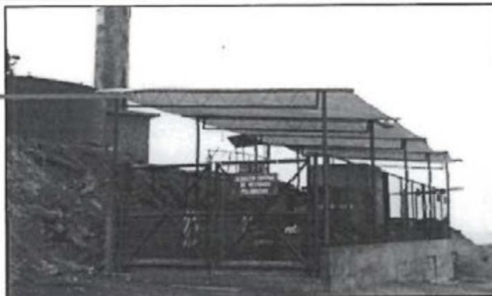
41. Shougesa indicó que el techo implementado se compone de una estructura metálica de cinco (5) secciones, cubiertas con una lona de policloruro de vinilo (pvc) de alta resistencia, 100% (cien por ciento) impermeable, antihongos, con protección UV y retardante al fuego. El techo es desmontable debido a que se realizan maniobras de carga y descarga de cilindros desde el exterior al interior con la ayuda de un camión grúa.
