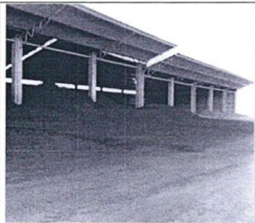
Foto N° 18: Almacenamiento de carbón en área cercada y techada.
