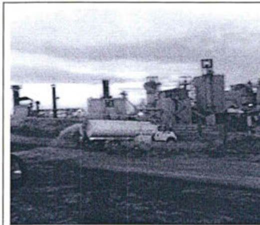
Foto N° 16: Regado de vía de acceso a la planta de cemento Caracoto.
