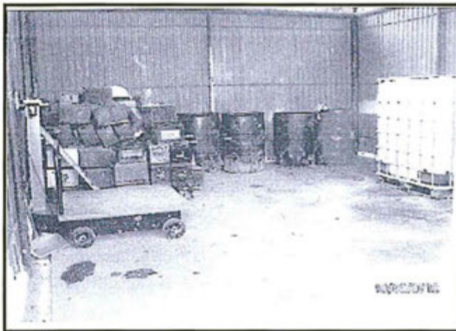
Foto N° 67. Jibarito.- Depósito para residuos peligrosos, no tiene letrero de identificación, los contenedores para residuos peligrosos no tienen tapa ni rótulo de identificación. Las baterías están apiladas de manera inadecuada y mezclada con otros residuos no identificados. Coordenadas: E 0385709 X N 9696078.
