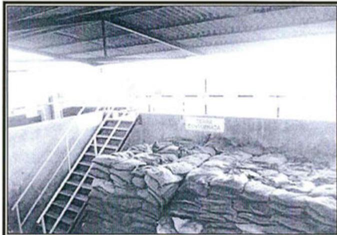
Granalla de segunda condición y tierra contaminada debidamente ensacados
