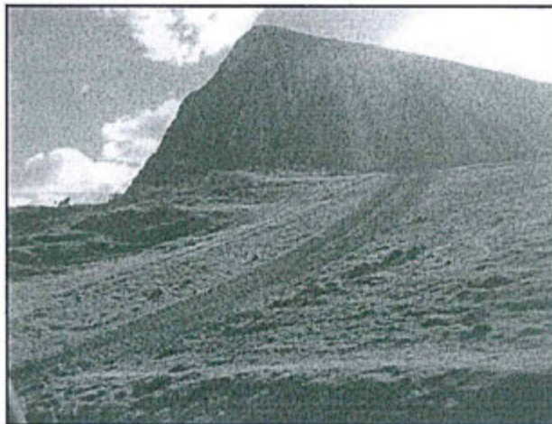
Foto 32: Vista de acceso improvisado con huella de tránsito de equipo en zona no autorizada y a ser remediada (Observación N° 1).
