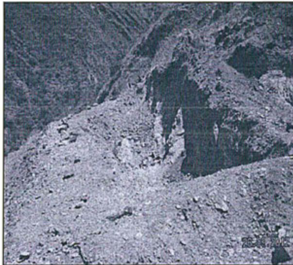
Foto 35: Vista del pozo de lodos de la plataforma de perforación SH12-PW2 sin remediar (Observación N° 2)
