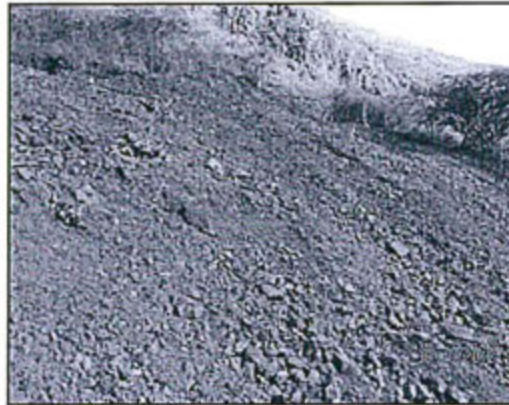
Vista de la plataforma SH12-WP2 después de la rehabilitación.
