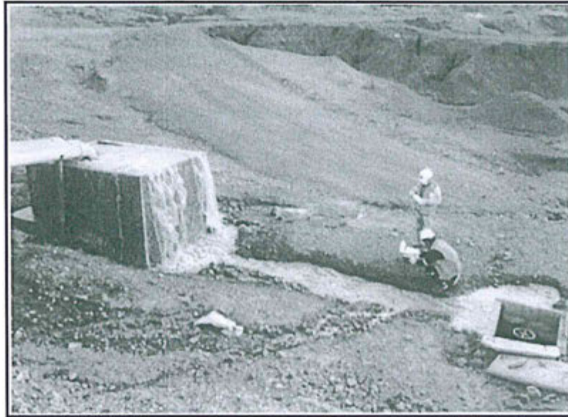
Fotografía N° 52. Agua que fuga de la caja de concreto proveniente de Socavón Smelter, va por curso natural hacia los pasivos ambientales mineros de Huachuacaja. Observación 2.b - Supervisión 2011. Estación de monitoreo (E-6).
