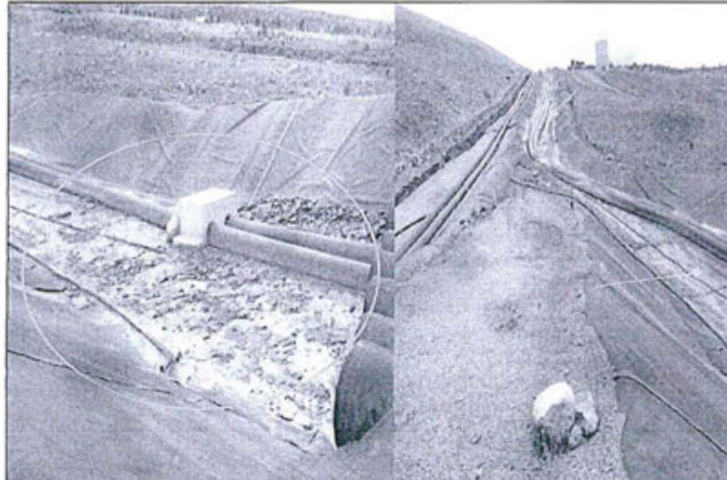
Fotografía N° 14.- Observación 4, supervisión 2011: Se observo que los canales impermeabilizados con geomembrana, que conducen las tuberías de HDPE que llevan solución rica al Pad de lixiviación 6, ubicado en el Pad de lixiviación de Yanacocha Norte, se encuentra con sedimentos.
