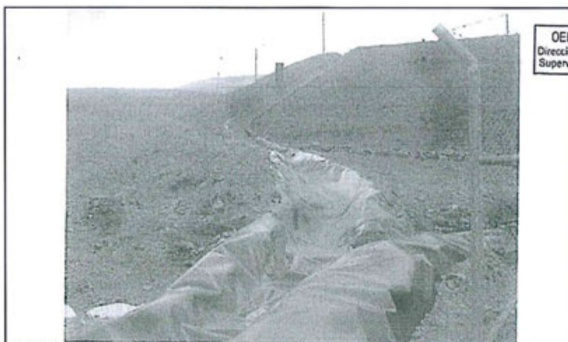
Foto N° 149. Cumplimiento de recomendación N° 2-2011: El recubrimiento del canal de drenaje cerca a la poza SUMP N° 5 ha sido completado con geomembrana asegurando su protección contra la erosión pluvial
