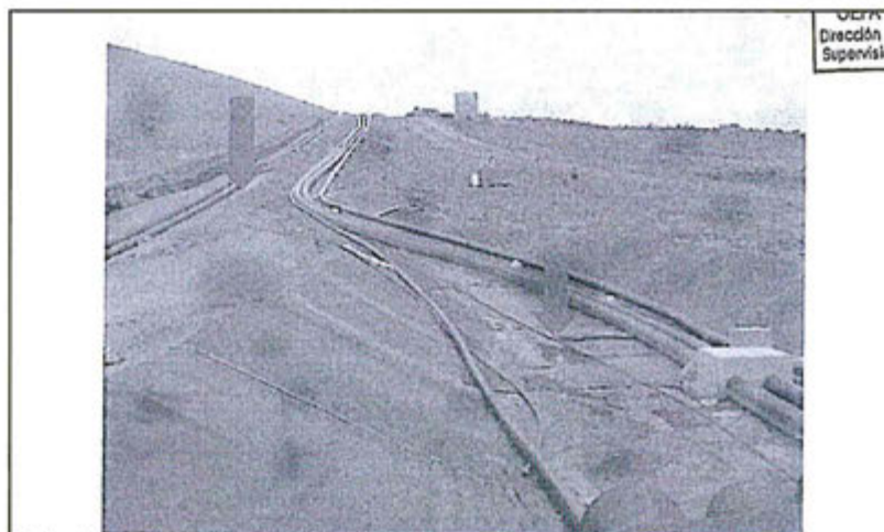
Foto N° 153. Cumplimiento de recomendación N° 4-2011: Vista del canal impermeabilizado con geomembrana con las tuberías de conducción de HDPE sin sedimentos.
