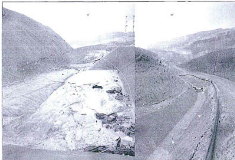
Fotografía N° 15.- Observación 4, supervisión 2011: Se pudo observar la presencia de sedimentos sobre el canal (revestido con geomembrana) donde conducen las tuberías de HDPE, ubicado en el Pad de Lixiviación Yanacocha Norte.
