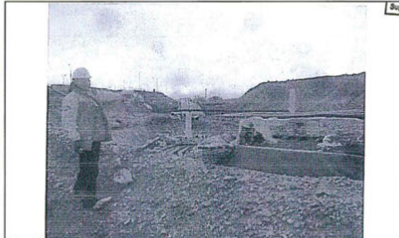
Foto N° 151. Cumplimiento de recomendación N° 3-2011: Verificación por la supervisora Letis Saavedra de los sacos reemplazados como soporte de las tuberías de conducción de agua al costado de la poza de pretratamiento AWTP Este-Pad Carachugo.
