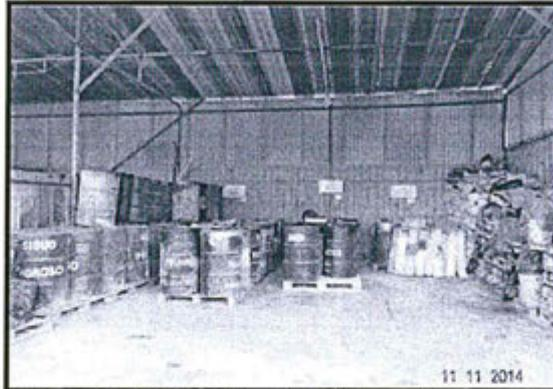
"Foto N° 19: Vista fotográfica de residuos peligrosos (aceites, grasas y residuos de hidrocarburos) acopiados en el interior del área 1, que conforma el almacenamiento central de residuos sólidos, sin contar con sistemas de contención"
