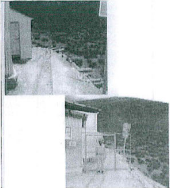
Foto 6.3: Caseta de lámpara del Taller de Mantenimiento del nivel 4250, sin residuos industriales y con puerta de seguridad.
