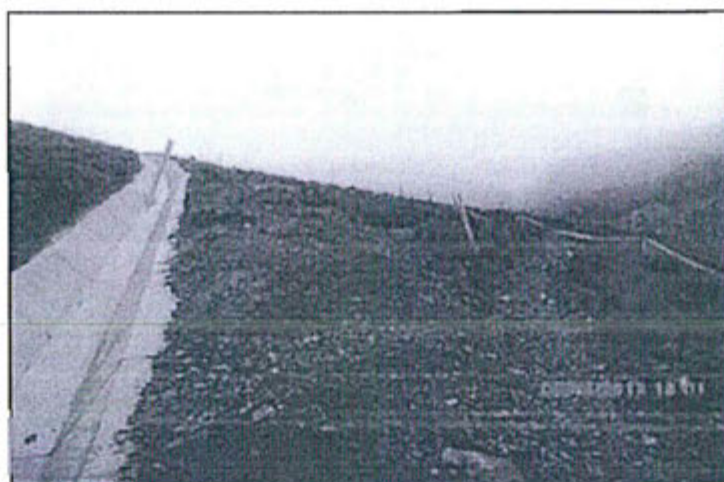
Fotografía N°03: Canal de coronación del depósito de desmonte Sansón revestido con cemento.
