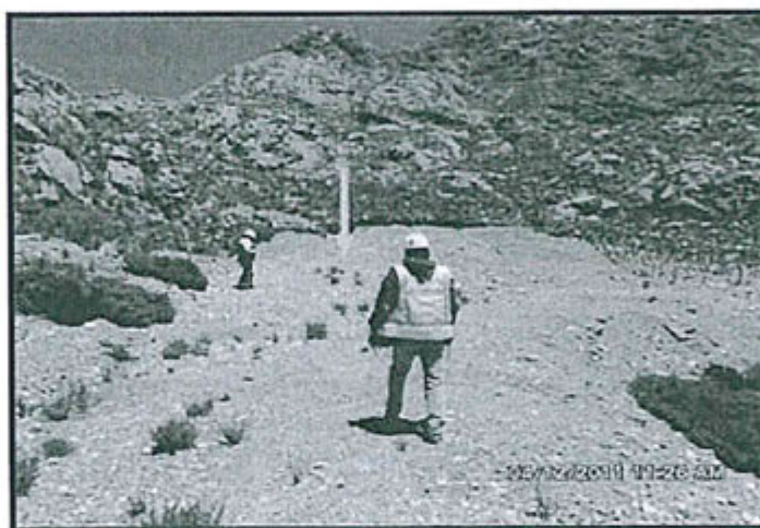
Foto 7: Plataforma con coordenadas 296554 E y 8818233 N, ubicada frente a la bocamina 4530, no se encuentra remediada.
