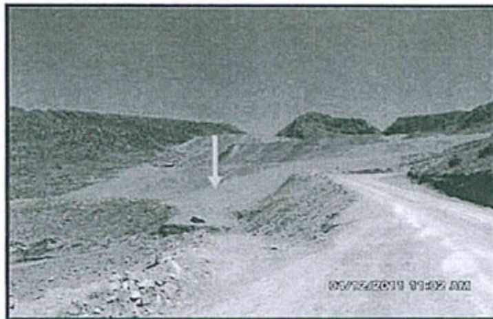
Foto 6: Botadero de desmonte denominado Sansón no cuenta con letrero de identificación, delimitación de área ni canales de derivación.
