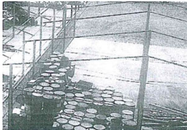
Imagen 6. Depósito de residuos sólidos pavimentado
