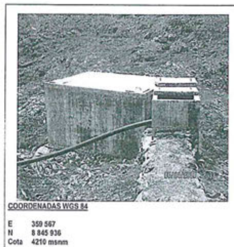
Imagen 05.- Cajas de registro por donde pasa el agua residual doméstica
