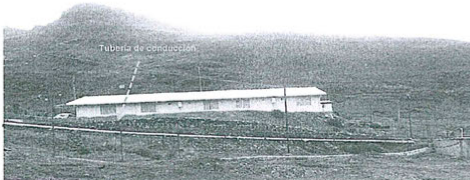
Imagen 02. Tubería de conducción
