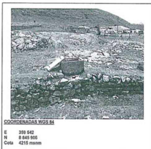
Imagen 05.- Cajas de registro por donde pasa el agua residual doméstica
