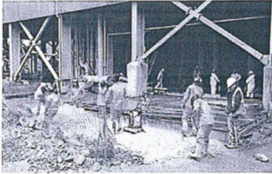
Imagen 9.- Trabajos de terreno, armado de fierro y encofrado de la losa
