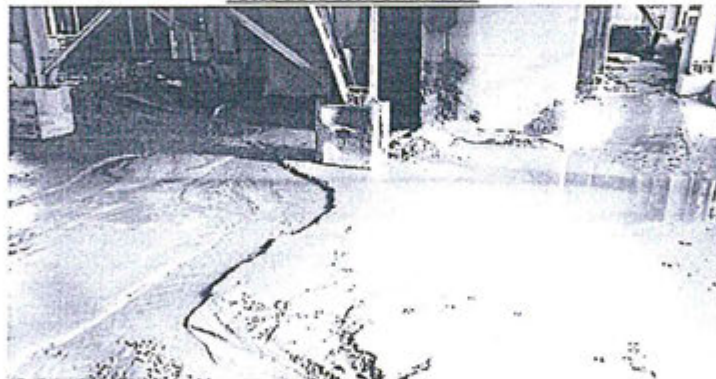
Imagen 6.- Losa bajo faja transportadora CV001 Fuente: Gold Fields 9 .
