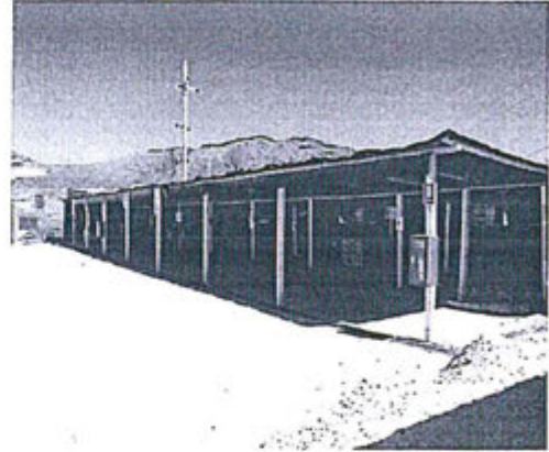
Foto N°2: Vista del área de almacenamiento de aceites, grasas, envases vacíos, entre otros similares; dentro del almacén de residuos peligrosos (VOLPAD) de Cerro Corona
