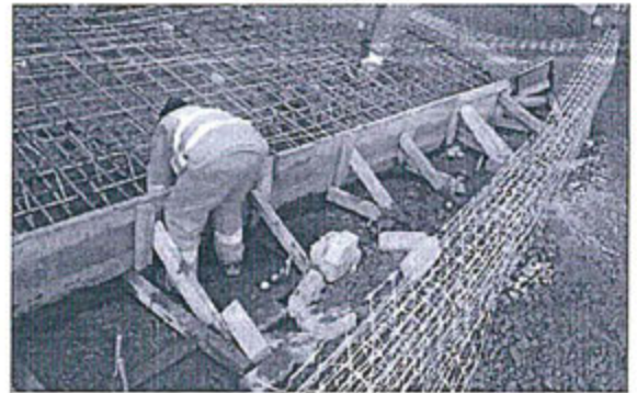
Imagen 9.- Trabajos de terreno, armado de fierro y encofrado de la losa
