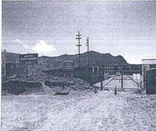
Foto N°1: Vista del almacén de residuos peligrosos (VOLPAD) de Cerro Corona
