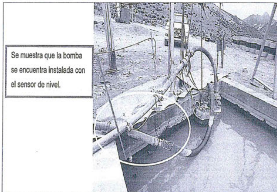
Fotografía N° 4: Se observa la poza con los dos sensores de nivel de activación automática.
