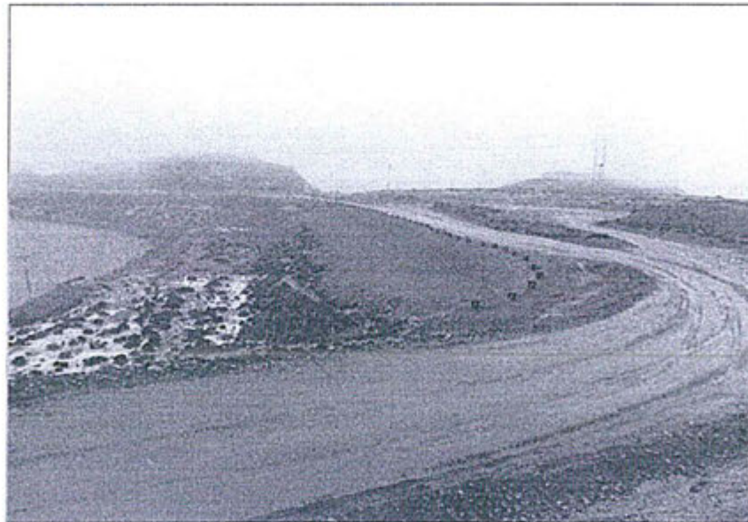
Fotografía N° 8: Se observa el área donde se retiró el material de concreto, totalmente limpia.
