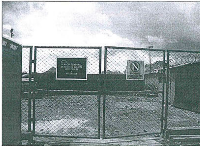
Fotografía N° 13: Vista de la disposición con letrero informativo del área destinada como "Almacén Temporal de Residuos Sólidos Industriales y Peligrosos".
