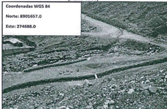
Fotografía 3: Canal de captación al pie de la desmontera. (Folio 1366)
