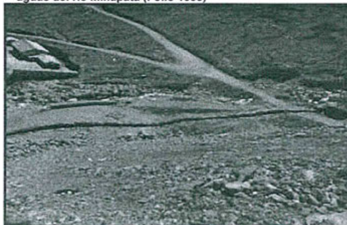
Fotografía 6: Canal de captación al pie de la desmontera para evitar el contacto de cualquier tipo de drenaje con las aguas del río Minapata (Folio 1335)
