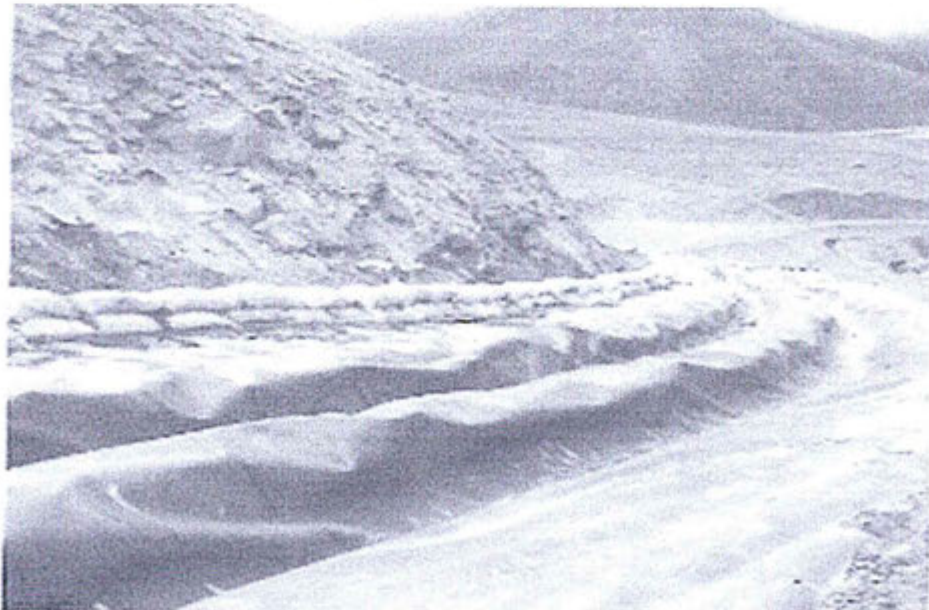
Imagen 14: Anclaje al pie del talud
