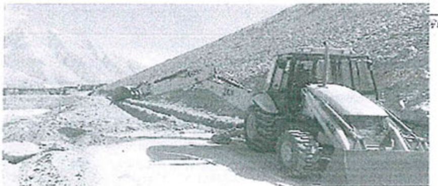
Continuación de los trabajos del canal de coronación y del canal de contingencia de Tubería de relave.
