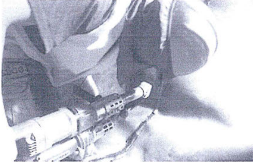
Imagen 14: Anclaje al pie del talud
