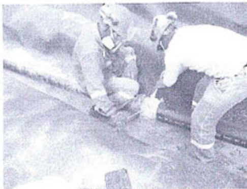
Colocación de uniones de tubería
