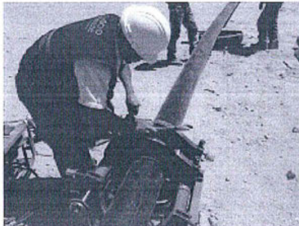
Se abren las masas de obra para instalar las tuberías en el canal de contingencia de Tubería de relaves.
