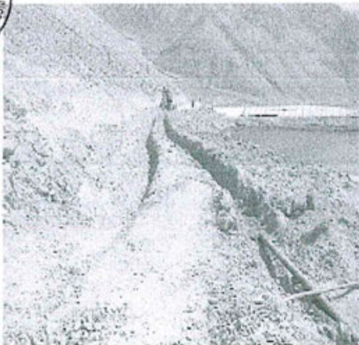
Se continúa con la construcción del canal de conexión y del canal de contingencia de tubería de relaves.
