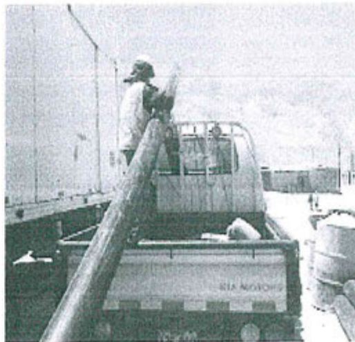
Trasladando las tuberías hacia el canal de contingencia de tubería de relaves.
