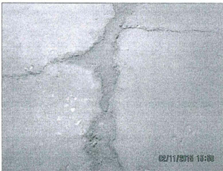
Fotografía N° 13: Patio N° 1 donde se muestran las grietas selladas con concreto
