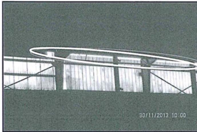
Fotografía N° 15 Hallazgo N° 01 Existe un tramo de aproximadamente 20 metros lineales por 10 centímetros de ancho en un lado de la pared del almacén de concentrados de plomo. El almacén no se encuentra hermético ni cerrado.
