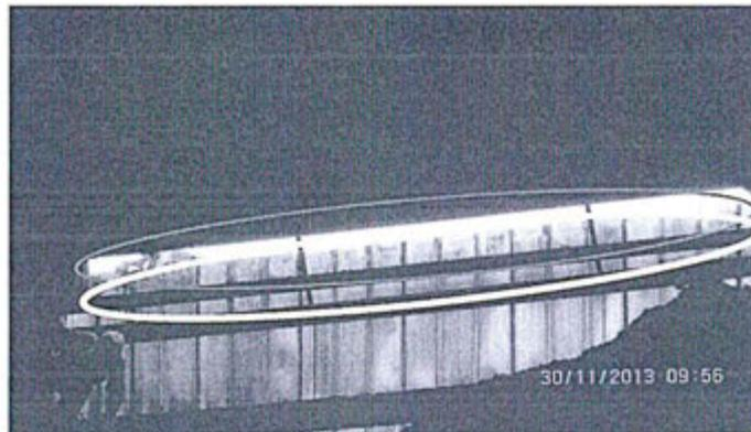
Fotografía N° 11 Hallazgo N° 01 Existe un tramo de aproximadamente 4 metros lineales por 10 centímetros de ancho en un lado de la pared del almacén de concentrados de plomo. El almacén no se encuentra hermético ni cerrado.
