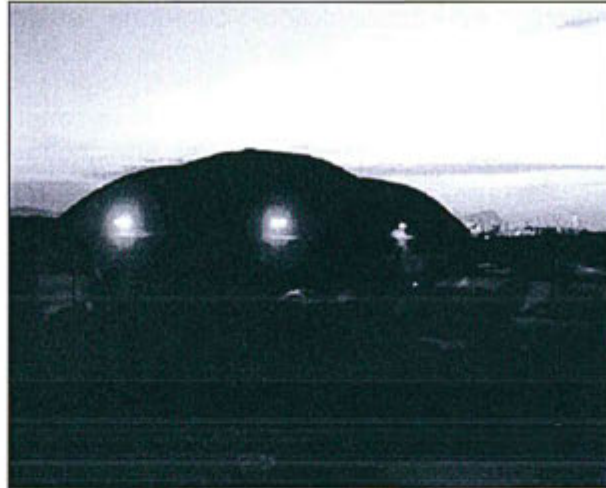
Foto N° 03, rumas de concentrados cubiertas con mantas de polipropileno.
