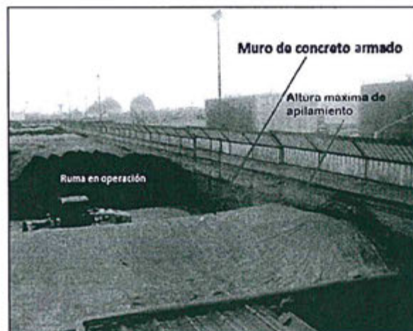
Foto N° 1: esquema general de apilamiento de rumas en el patio de operaciones. Vista desde oficinas piso superior.
