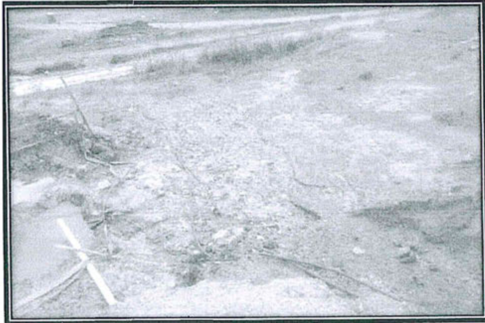
Foto N° 10, Observación N° 06.- En la plataforma de perforación diamantina con código de sondaje SH11-322, se observa la poza de captación de lodos con rasgos de rebose de dichos lodos por ingreso de aguas de escorrentías, impactando al suelo.
