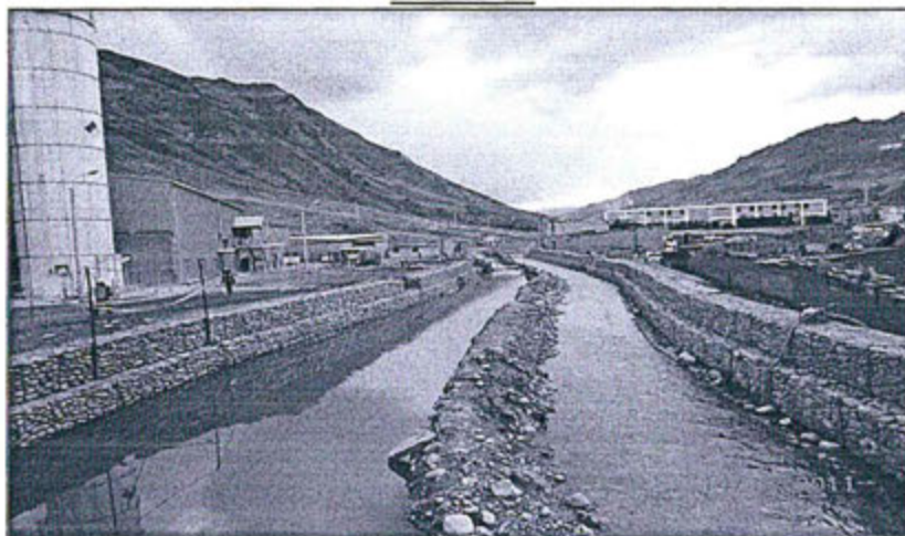
Foto N° 56. Protección de las defensas ribereñas del río Yauli.
