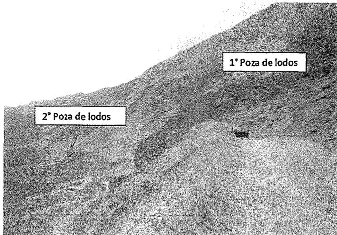
Fotografía N° 20: Se observa las dos pozas de sedimentación de lodos de perforación, 1° poza de lodos ubicada en E 770678 – N 8386292, la 2° pozas de lodos ubicada en E 770676 – N 8386300, ambas pozas cuentan con base de plástico color celeste.
