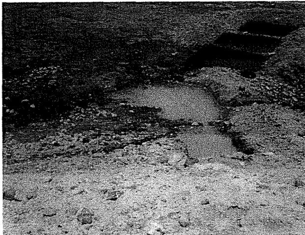
Fotografía N° 32: El agua con sedimentos que es generada en el corte de los testigos, son derivados a cinco pozas de sedimentación las cuales son descargadas al ambiente mediante filtración.
