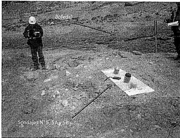
Fotografía N° 6: Plataforma de perforación donde se observa los sondajes N° 5, 5A y 5B, ubicado en E 770014 – N 8387220, la plataforma no cuenta con sistema hidráulico para evitar arrastres de sedimento al bofeda ubicado a menos de 12 m aprox.
