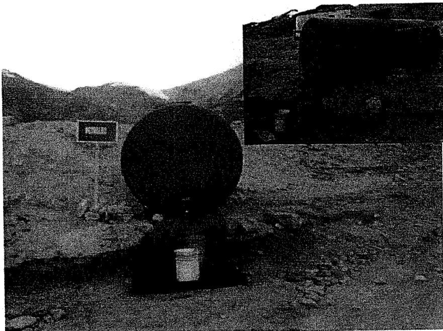
Fotografía N° 30: Se observa tanque de combustible ubicado (E769286 – N 8387084) en el campamento de contrata, el tanque no cuenta con sistema de contención en caso de derrames.
