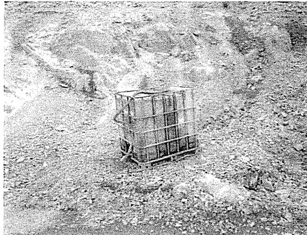
Fotografía N° 11: En inmediaciones de la plataforma de la perforación del sondaje 41 se encuentra almacenado un tanque de combustible el mismo que no cuenta con estanca de seguridad.
