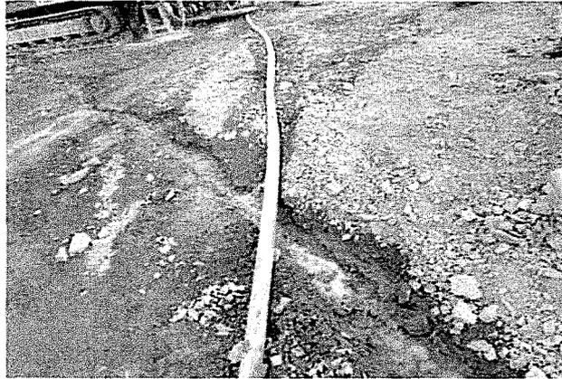
Fotografía N° 17: Fuga de aguas con contenidos de lodos de perforación, discurría por la plataforma de perforación y talud de la vía de acceso, las cuales llegaban a un bofedal.
