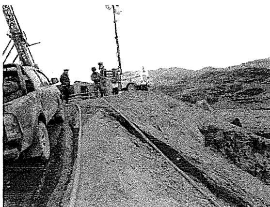
Fotografía N° 15: Aguas que ingresan a la perforadora discurrían por la plataforma y talud de la vía de acceso hasta el bofedal. Dichas aguas eran turbias por el arrastre de sedimentos.
