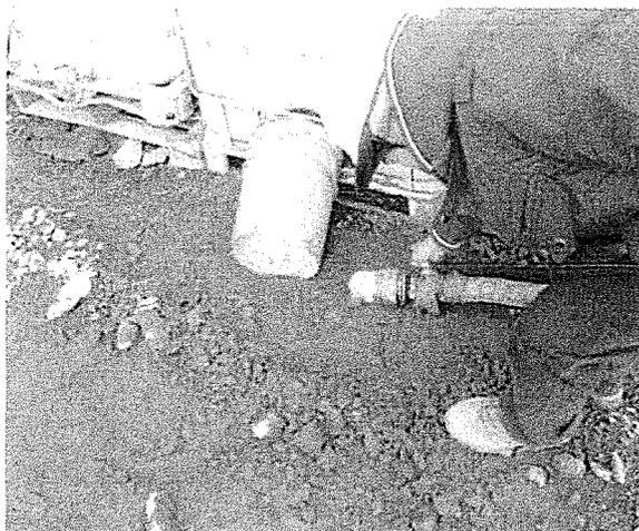
Fotografía N° 14: Aguas que se usan en la perforada discurrían por la plataforma de perforación, debido a problemas presentados en la válvula de la manguera.
