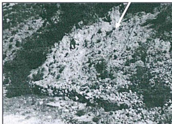
**Fotografía N° 91:** Plataforma Ant-75-10, obsérvese la falta de nivelación y revegetación
