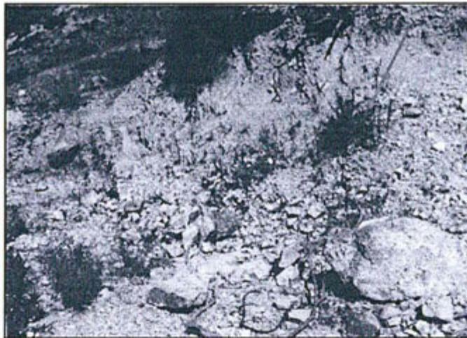
**Fotografía 93:** Plataforma Ant-29-08, obsérvese la falta de nivelación y revegetación
