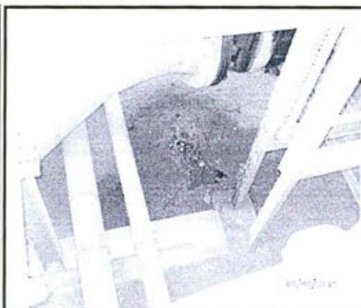
Foto N° 3 Nueva Unidad de Tanques: Piso impregnado con hidrocarburo en el área estanca debajo de la válvula de salida del Tanque 31T - 1S, en un área aprox. De 1 X 2 M.
