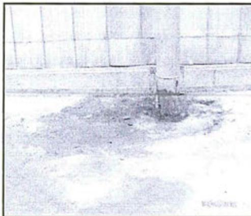
Foto N° 4 Nueva Unidad de Tanques: Piso impregnado con hidrocarburo en un área aprox. De 2.5 X 2 m en el área estanca, alrededor de la bandeja de contención, debajo del tubo de venteo del Tanque 303 de crudo reducido. Además de la bandeja se encuentra deteriorada (tiene huecos)
