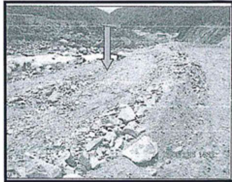
Vista 6: DME-1 falta reperfilar.
