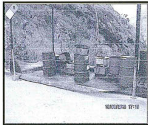
Vista 16: Sin cerco perimétrico, señalización ni extintor contra incendio.
