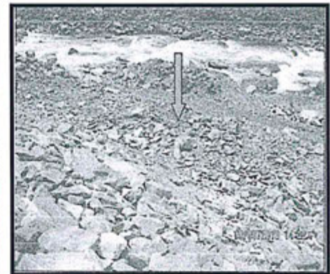
Vista 8: DME-6 requiere reperfilado.
