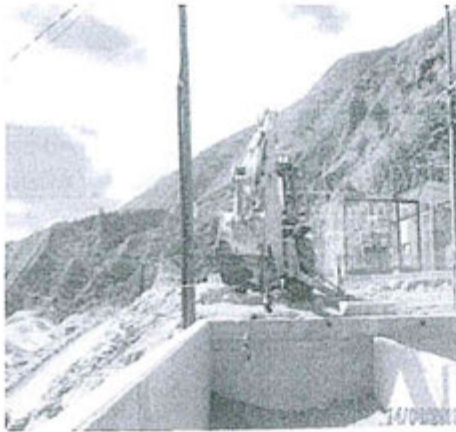
Limpieza con retroexcavadora
