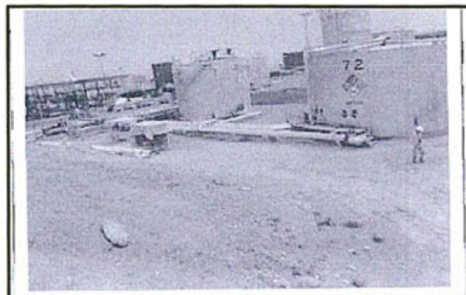
Fotografía N° 39: Vista panorámica de la zona en donde se ubica los tanques 72 y 36, obsérvese que los tanques no cuentan en su alrededor con un dique completo de contención.
