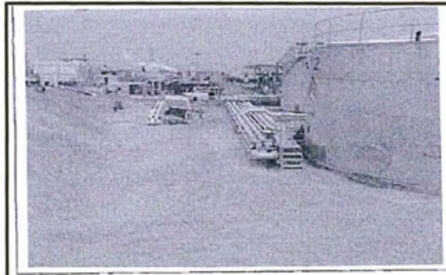
Fotografía N° 36: Vista panorámica de la zona donde le falta completar el dique de contención de los tanques 72 y 36.
