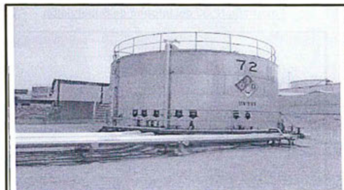
Fotografía N° 35: Vista panorámica de las tuberías del Tanque N° 72, en donde se observó aproximadamente 12 m 2 de suelos afectados con hidrocarburos.
