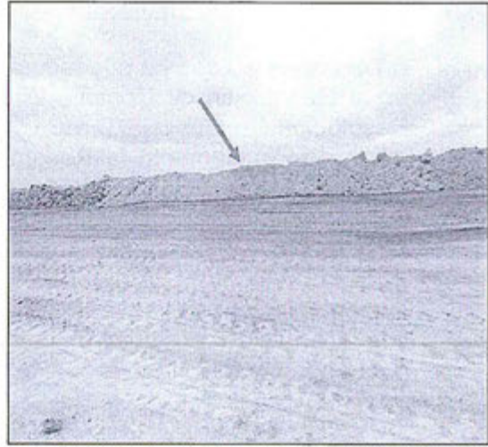
Fotografía N° 06: Otra vista de la berma de protección temporal interna Oeste (lado norte) construido con material estéril. Sirve de protección de una ocurrencia de aguas de escorrentías del FEN y protege el tajo, desmontes y demás componentes.
