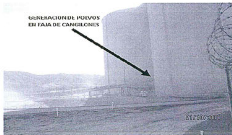
FOTO N° 2.28.: Tolvas de almacenamiento de concentrado seco. Se observa gran generación de polución aérea en la zona de unión entre la faja transportadora y la faja de cangilones al pie de las tolveras. Observación N°9 – Regular 2010.
