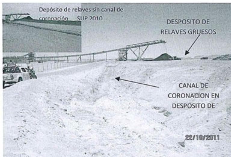
FOTO N° 2.11.: Observación N 7 – Regular 2010. Canal de coronación en los depósitos de relaves gruesos. Corre paralelo al acceso principal de ingreso a la mina. A la izquierda se encuentra la PC.
