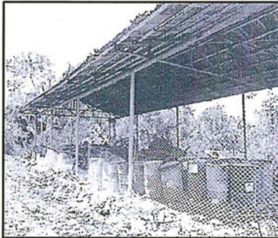
Fotografía N° 1 (Anexo J) de los descargos
