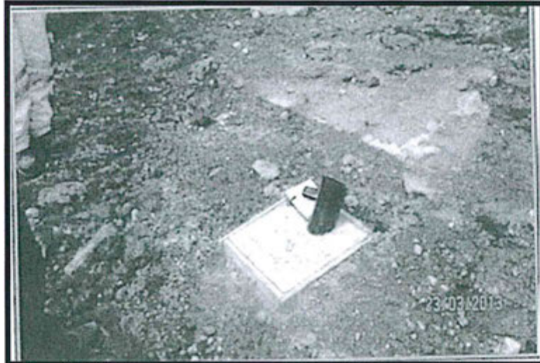
Fotografía N° 18 del Informe de Supervisión: Plataforma detectada que no se encuentra aprobada en los instrumentos de gestión ambiental. Coordenadas UTM WGS 84 293165E, 8831168N
