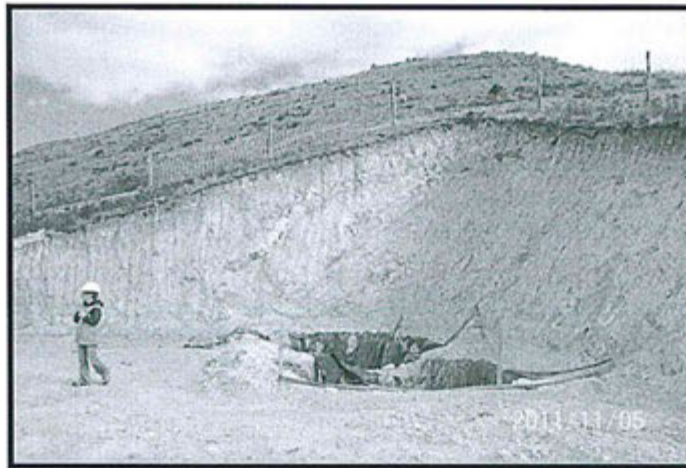
Fotografía N° 16: La plataforma de los sondajes MI09-DH 003/024, carecen de impermeabilización y cerco de protección para las pozas de lodo. El sondaje DH 003 finalizó el 30.08.2009, con una profundidad 1068 metros y el sondaje DH 024 finalizó el 21.11.2009, con una profundidad 174.65 metros.
