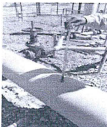
Imagen 4: trabajos de mantenimiento en el tubo visor y conexiones.
