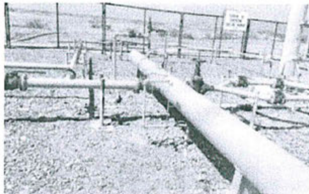
Imagen 7: Trabajos de mantenimiento en el tubo visor y conexiones
