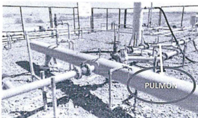
Imagen 3: trabajos de mantenimiento en el tubo visor y conexiones
