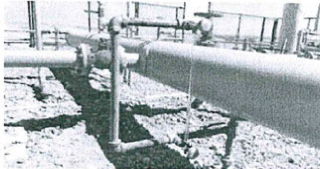
Imagen 6: trabajos de mantenimiento en el tubo visor y conexiones.
