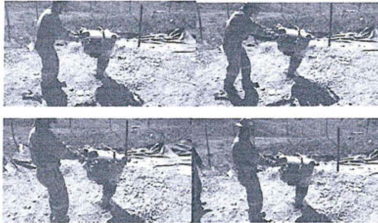
Fotografía 12: Compactación con el apisonador manual del suelo natural como cobertura de los residuos sólidos. (Folio 648)
