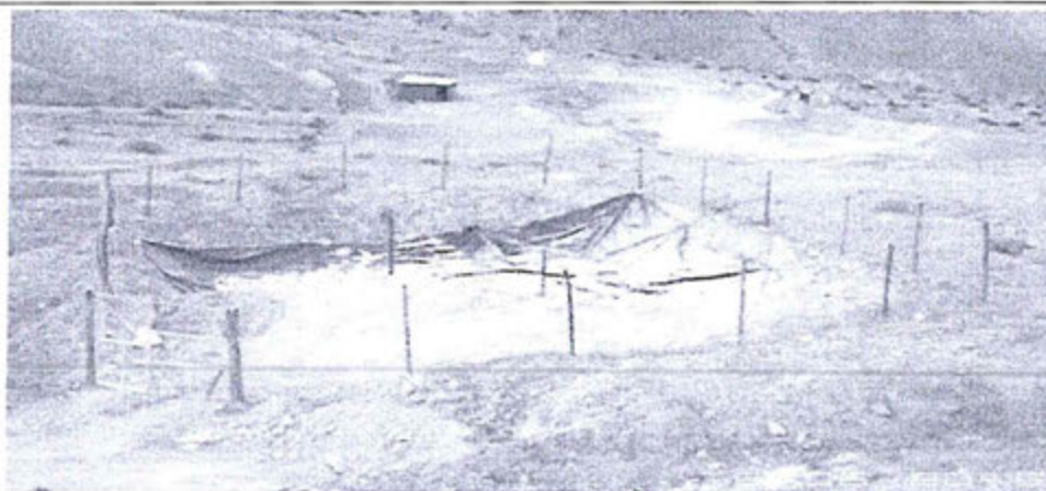
Fotografía 12: Condiciones finales del relleno sanitario. (Folio 649)
