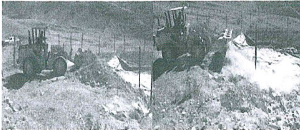
Fotografía 10: Colocación del suelo natural como cobertura de los residuos sólidos. (Folio 647)
