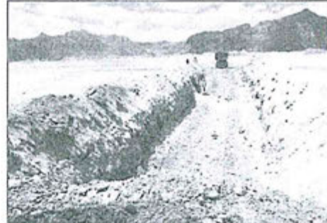
Imagen 12: Serie fotografía del proceso de encapsulamiento de residuos
