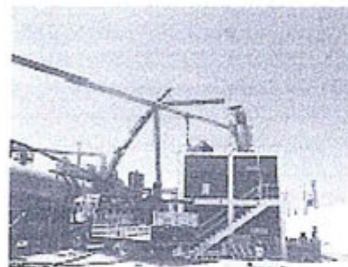
Fotografía que muestra el vehículo grúa durante la colocación del atrapa finos
